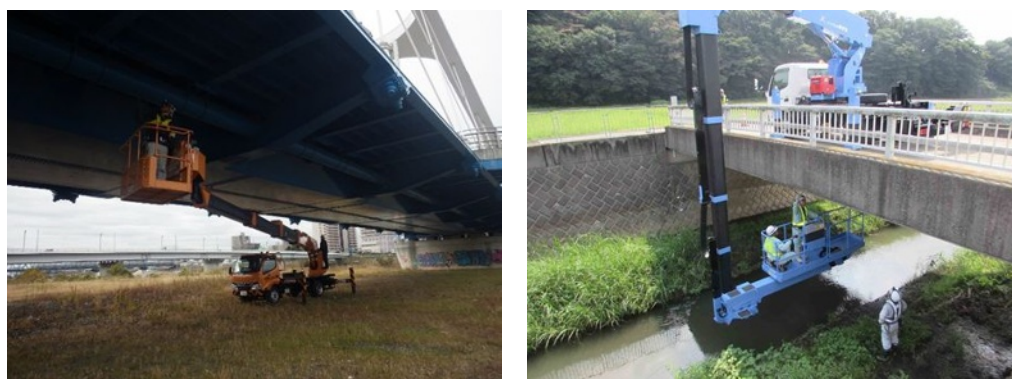
写真 6－1 橋りょう点検状況
