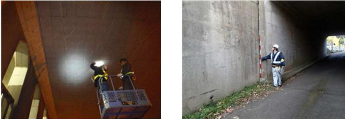
写真6-1 大型カルバートの点検状況
