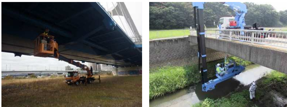
写真 6－1 橋りょう点検状況
