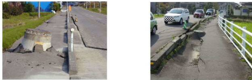
図2.8 大規模地震による下水道施設被害の状況（中期ビジョンより）
