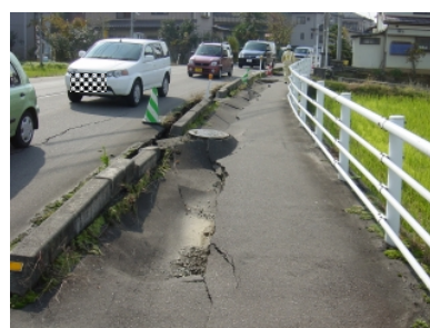
写真 大地震による下水道管渠の被害（中越沖地震）
