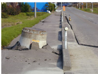
写真 大地震による下水道管渠の被害（中越沖地震）
