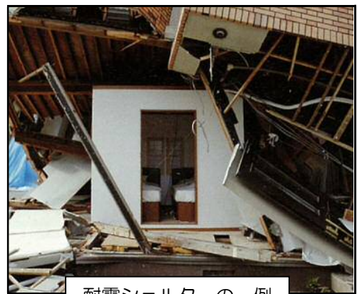
耐震シェルターの一例
