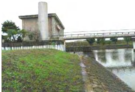
排水機場の法面での生育状況
