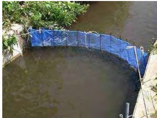
流出防止を目的とした網の設置例
