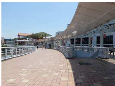
南側通路部全景（駅舎部側から）
