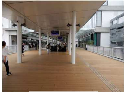
駅間部跨線部から中央部
