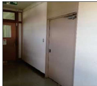
階段前に扉を設置し施設を分離
