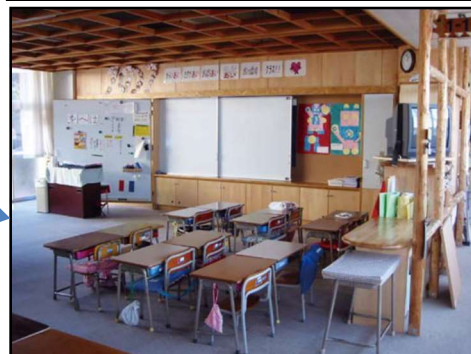
(改修後)内装を木質化
