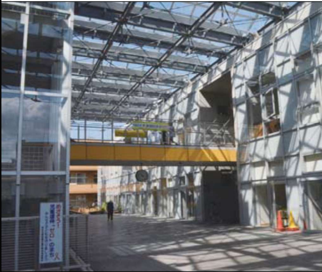
普通教室棟と生涯学習棟をつなぐ2階テラスとブリッジ
