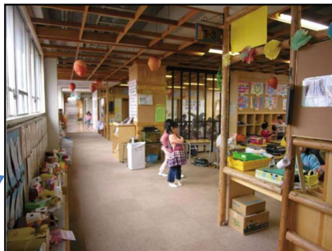
(改修後)廊下との間仕切りを撤去
