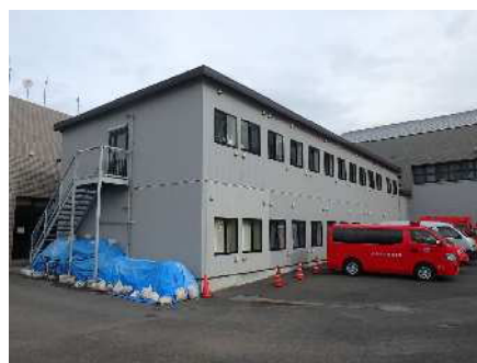
消防庁舎（増築棟）
