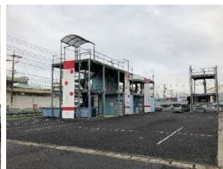
消防署南分署（訓練棟 C 塔（左）A 塔（右））
