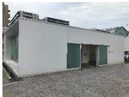
海老名駅西口公衆トイレ
