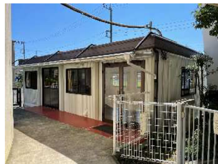
中新田保育園 増築棟②
