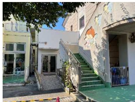
柏ヶ谷保育園 増築棟
