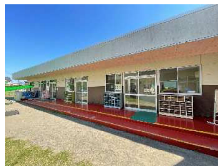
中新田保育園 増築棟①
