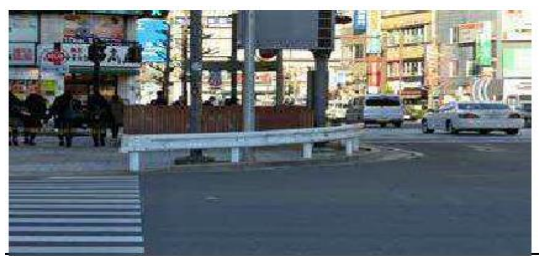
ガードレールの補修
