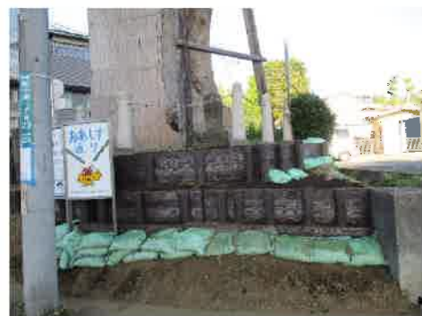
海老名の大櫓土留修理状況
