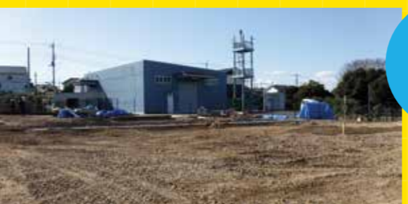
大型防災備蓄倉庫に隣接した約2,700㎡の土地を整備。平常時は消防訓練などに使用
