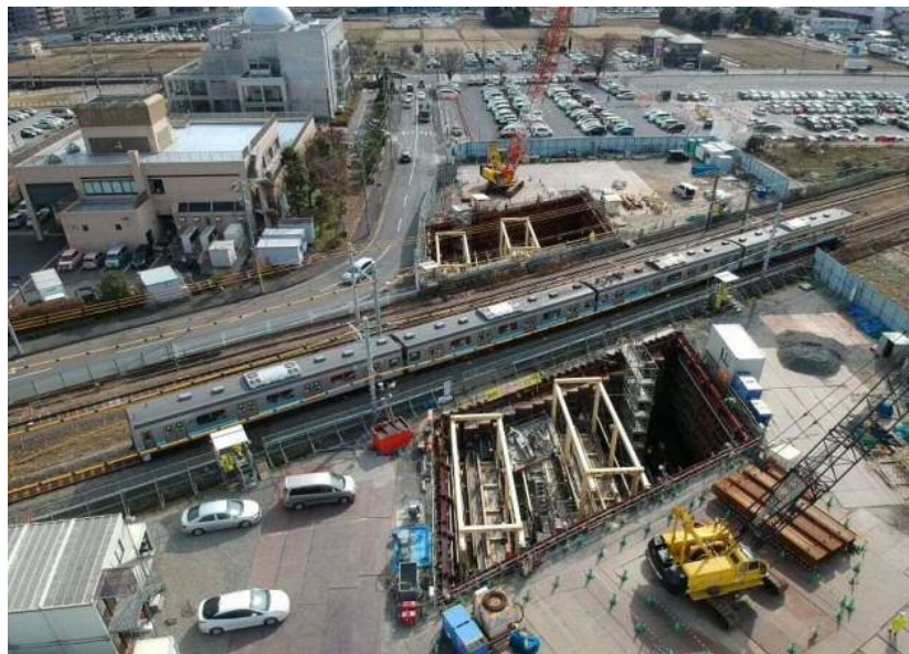
【JR相模線西側 ①現場事務所側より(ドローン撮影)】
