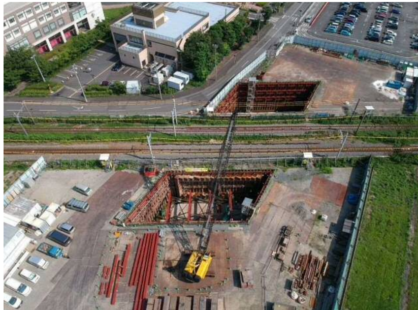
【JR相模線西側 ①現場事務所側より(ドローン撮影)】
