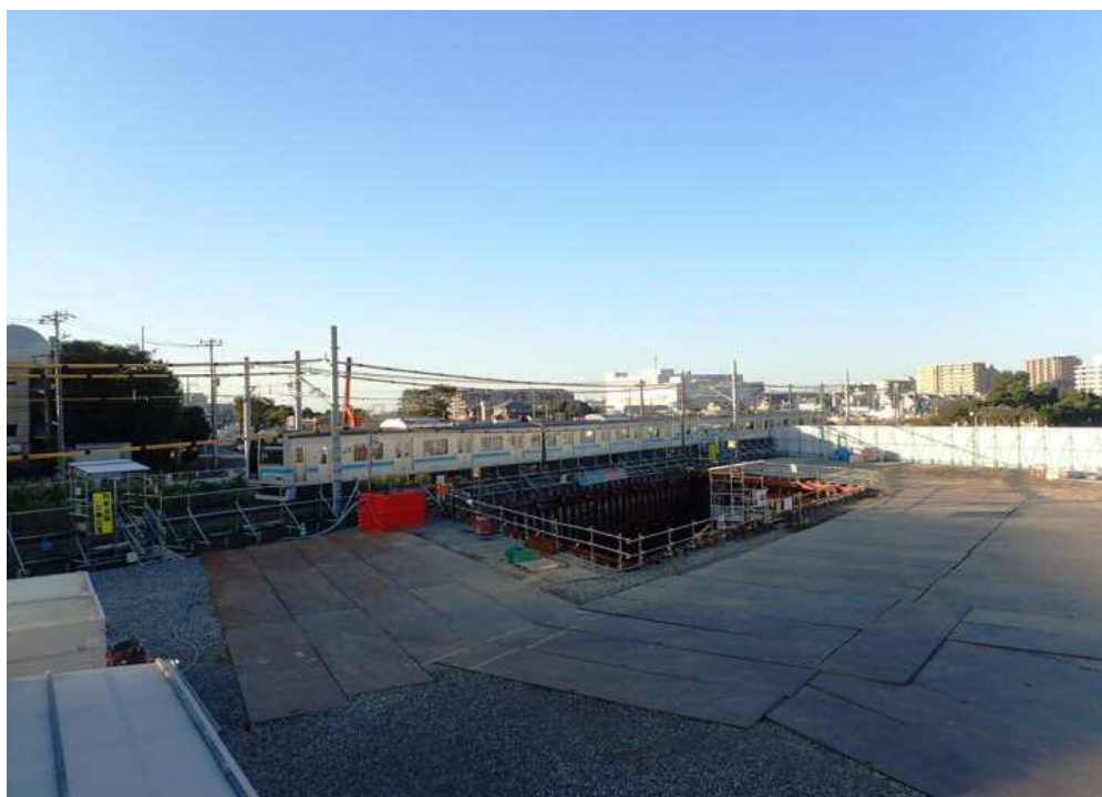
【JR相模線西側 ①現場事務所より】
