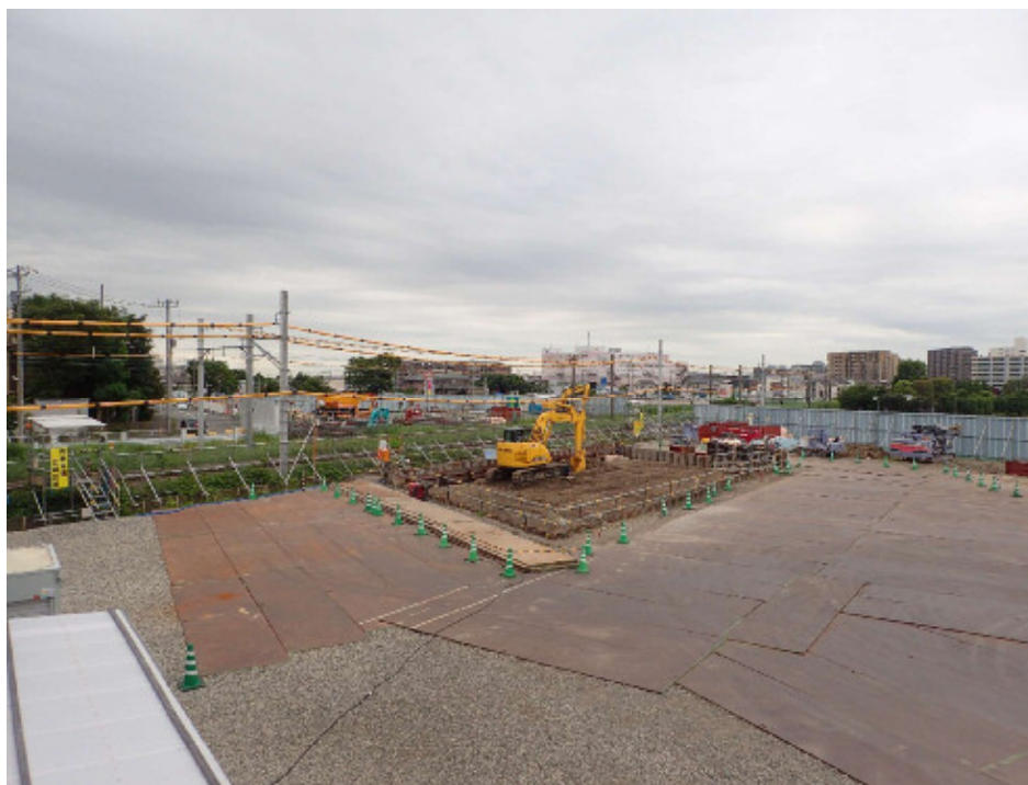
【JR相模線西側 ①現場事務より】 H30.6施行中
