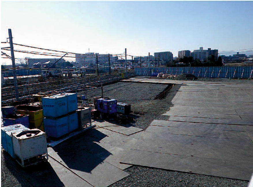
【JR相模線西側 ①現場事務より】 H29.12施行中
