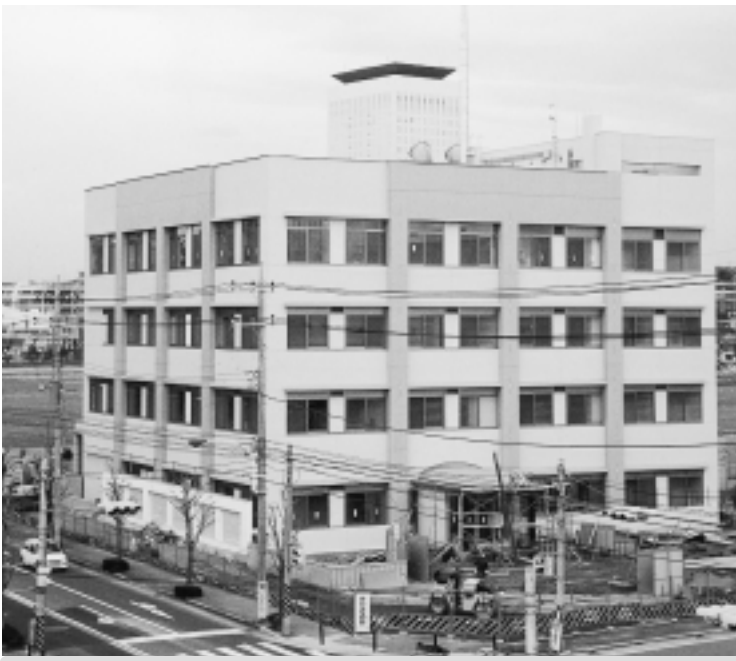
完成へ急ピッチで工事が進む海老名警察署
