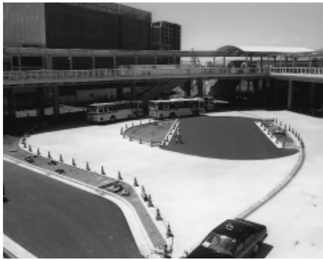
急ピッチで進む駅前ロータリー工事
