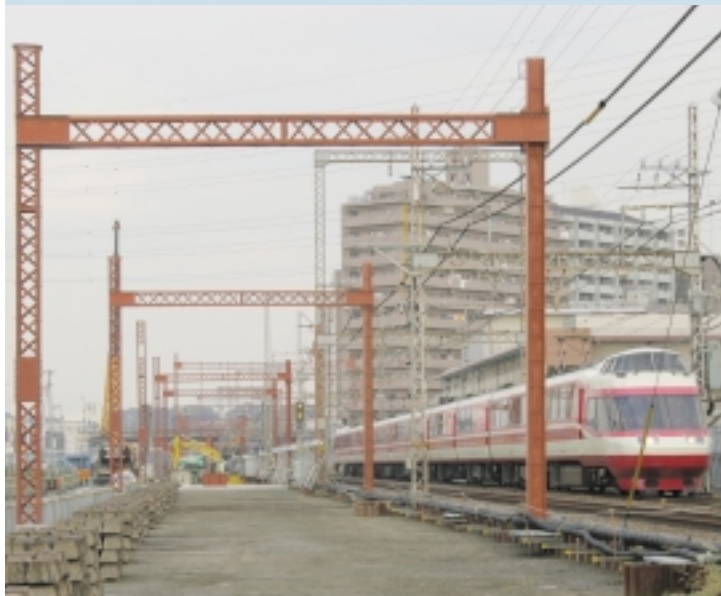
着々と進行する鉄道立体交差事業
