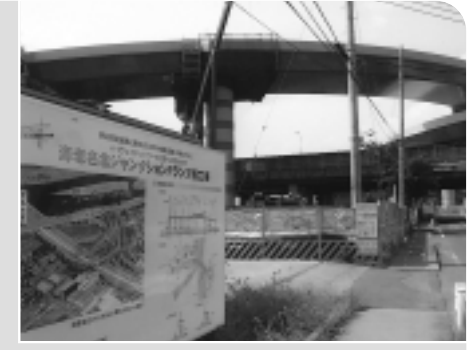
建設中のさがみ縦貫道路
