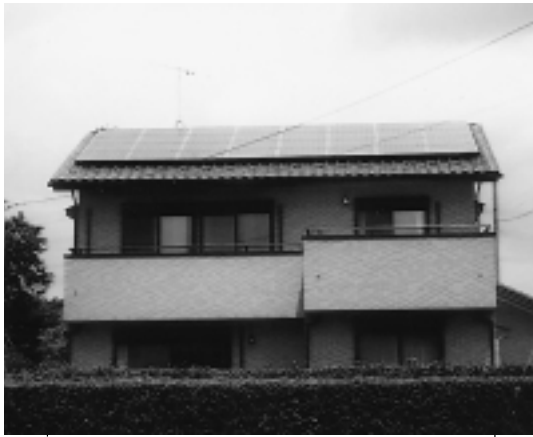
新エネルギーを設けた住宅もチラホラ…
