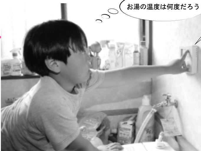
▲モニターで太陽熱の温度を確認
