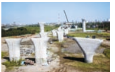
▲海老名運動公園付近の海老名北ジャンクション整備状況
