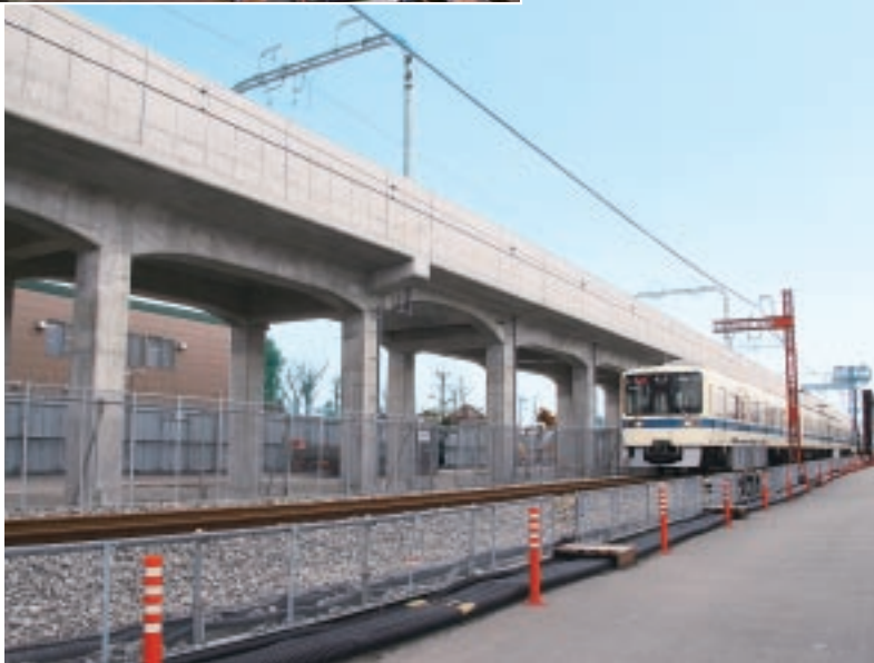
▲鉄道立体交差事業は、小田急線海老名駅～厚木駅間の鉄道高架化に向け、現在は、上り線を高架橋に切り替えるための工事などを進めています
