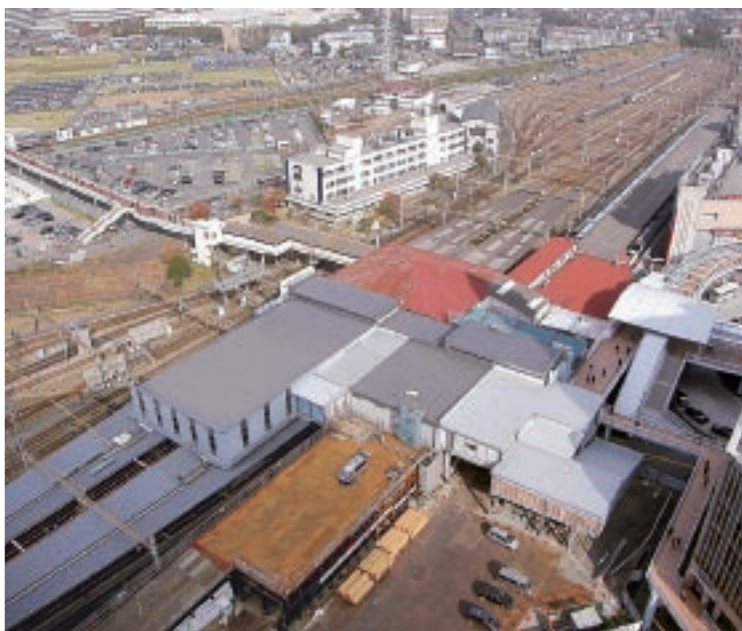
▶現在、海老名駅自由通路整備(小田急・相鉄駅舎部)事業は、平成22年の全面使用開始に向け、工事を進めています
