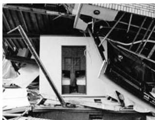
耐震シェルターの一例
