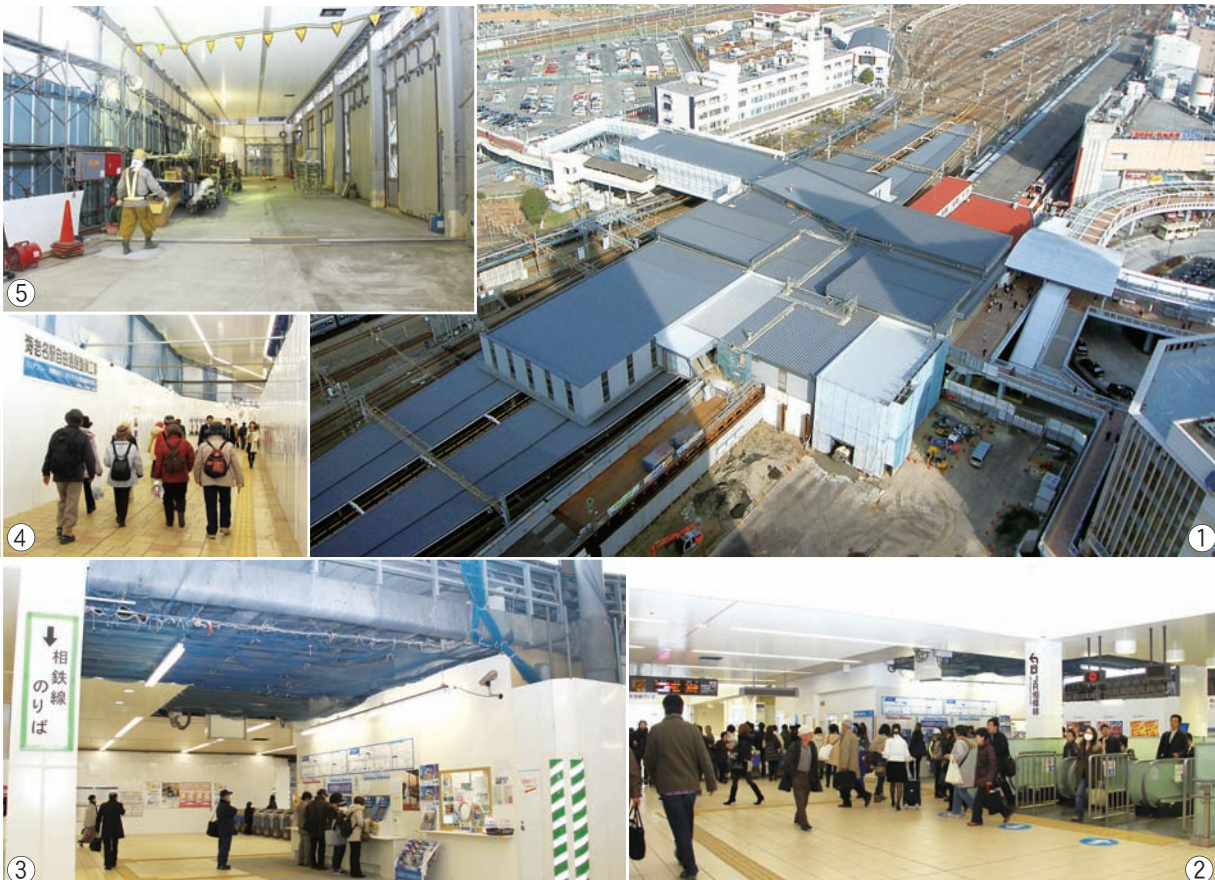
▲工事が進む海老名駅自由通路 ①駅舎部全景 ②利用を開始した小田急線の改札口とエスカレーター ③工事中の仮設券売機付近 ④JRへの連絡通路(自由通路一部完成部分) ⑤壁面と床を施工中の自由通路本体部分
