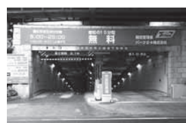
▲海老名中央公園地下駐車場
