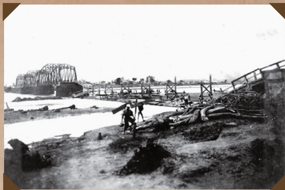
関東大震災で崩れ落ちた相模橋（宗珪寺所蔵）
