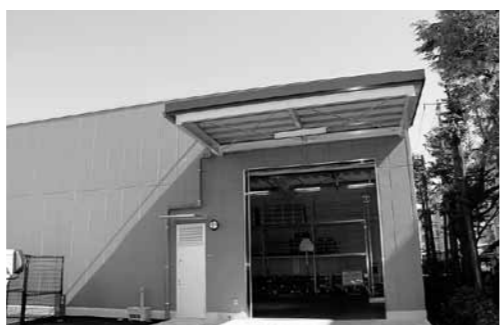
▲ 中部大型防災備蓄倉庫
