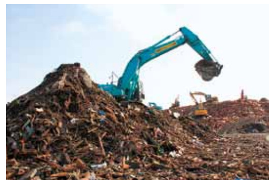
がれき仮置場
