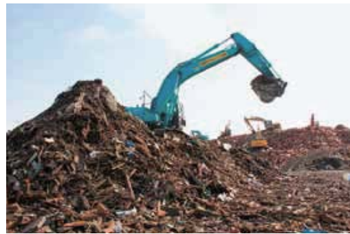
がれき仮置場
