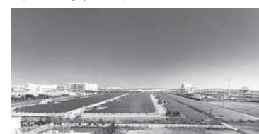
▲浮島太陽光発電所
