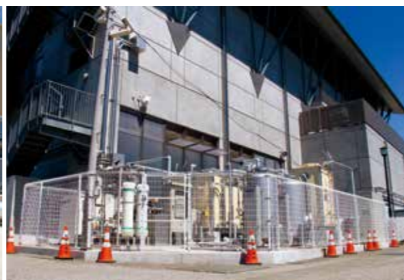
▲北部公園体育館裏に設置の地下水膜ろ過システム
