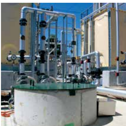
▲地下水をくみ上げる原水ポンプ
