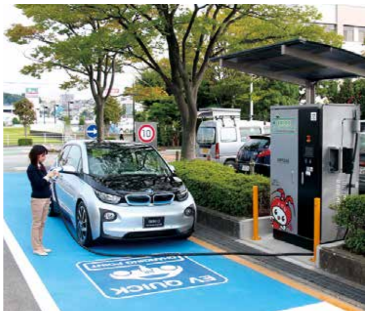
▲市役所来庁者駐車場入り口付近に設置の急速充電器
