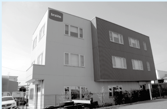
▲(株)ブレイズ・システム社屋 【主な業務】放送・業務用の映像・音声制作システム、映像・音声の監視システム、データ放送システムの設計・施工・保守管理
