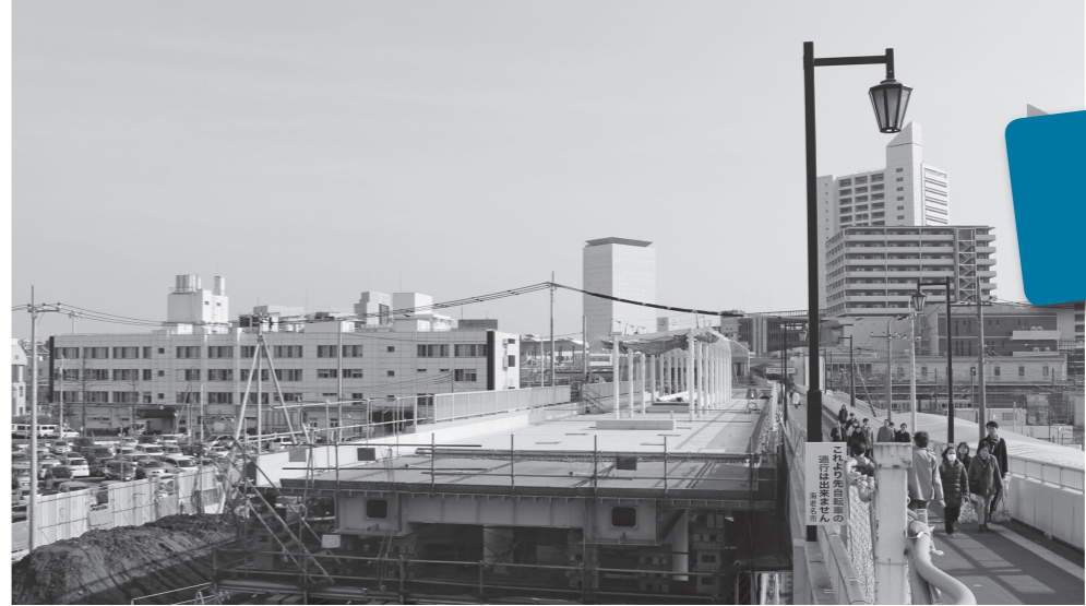
▲みみのり債を活用する、工事中的新自由通路 (JR・小田急海老名駅間)
