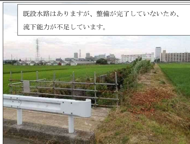
図 3.4-2 未整備水路の例（国分一号幹線）
