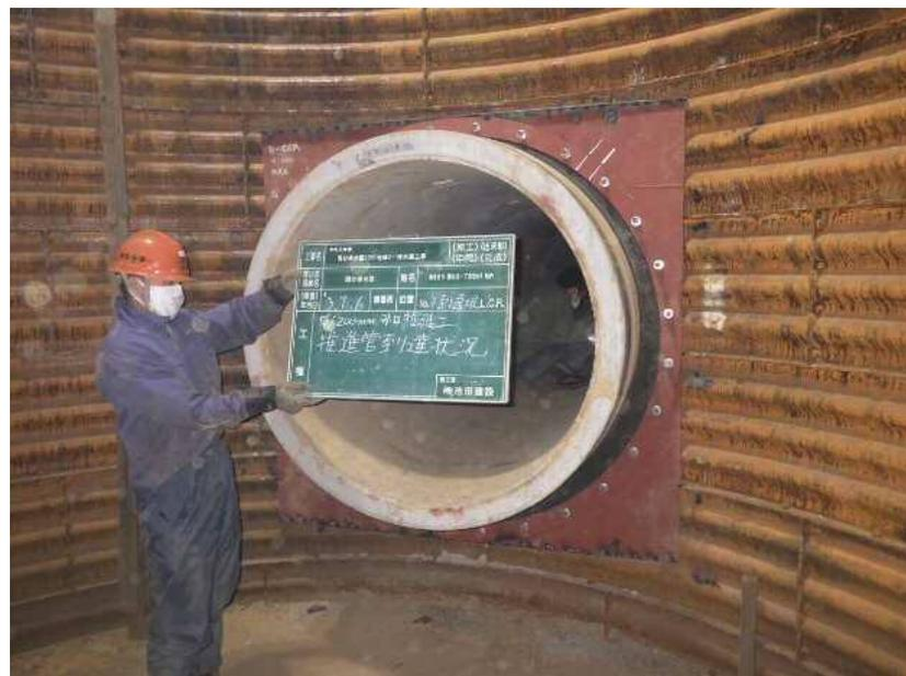
雨水管きよ整備状況 国分北一丁目地内 管径φ1200mm
