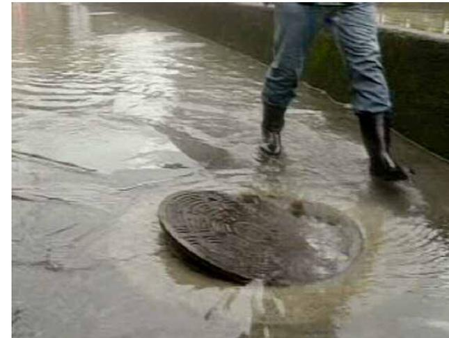
大雨により下水道管に大きな圧力がかかり、蓋が外れてしまった事例(国内)
