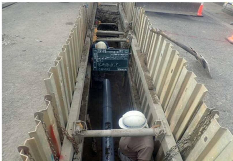
汚水管きよ整備状況 本郷地内 管径 $\Phi$ 200mm
