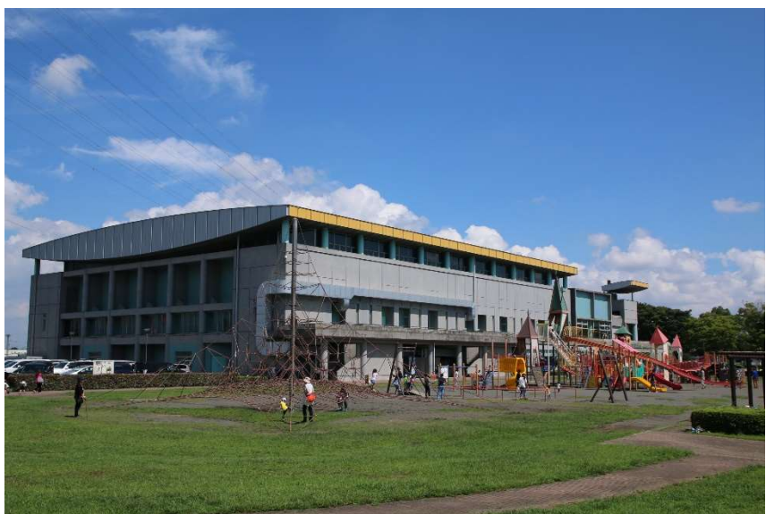
海老名運動公園総合体育館
