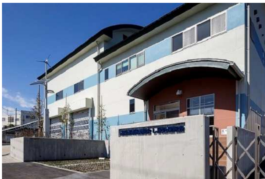
高座清掃施設組合水処理施設
