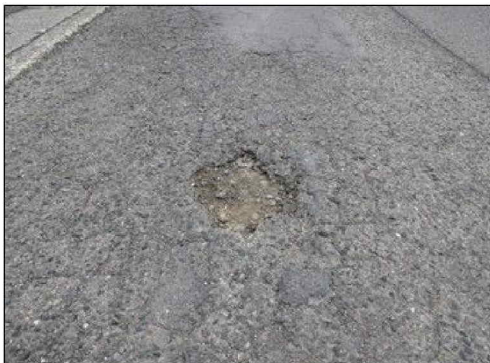
舗装補修（穴埋め前）
