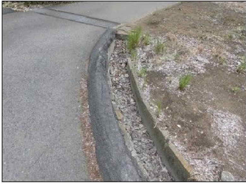
側溝清掃（落ち葉除去前）
