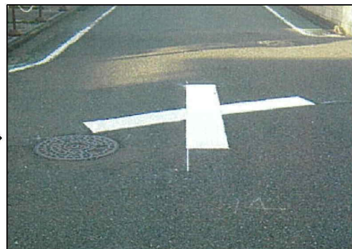
区画線の補修（補修後）
