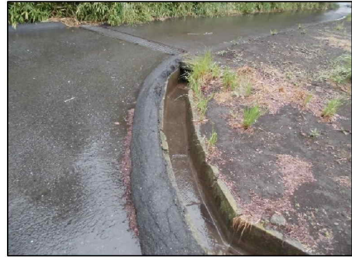
側溝清掃（落ち葉除去後）
