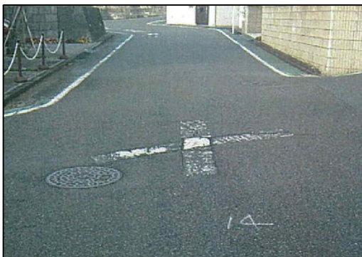
区画線の補修（補修前）
