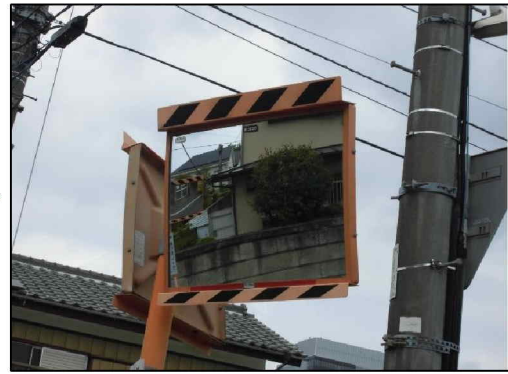
安全施設の補修（カーブミラー補修後）
