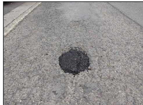
舗装補修（穴埋め後）
