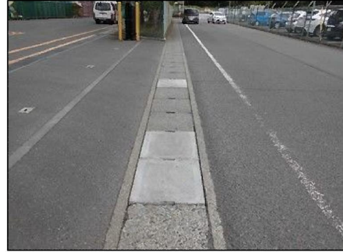
側溝の蓋の破損（蓋交換後）
