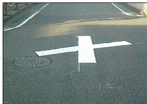
安全施設の補修（区画線補修後）
