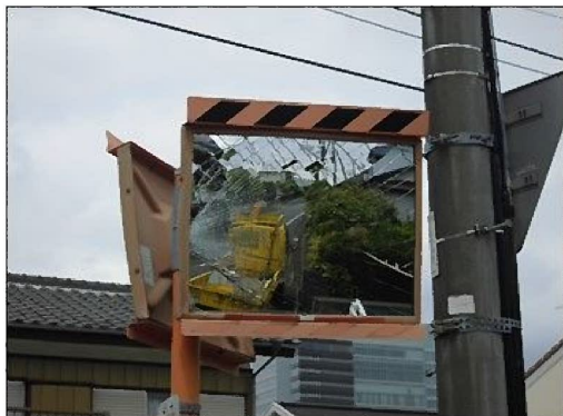
安全施設の補修（カーブミラー補修前）
