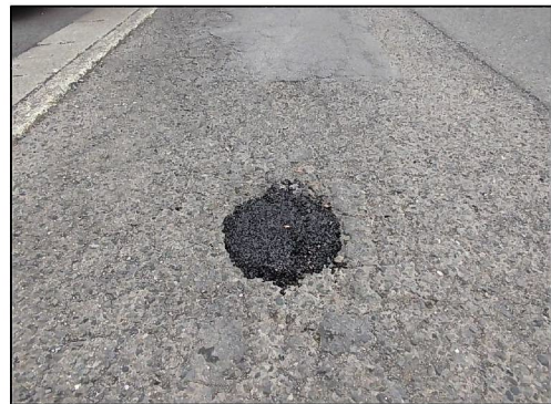
舗装補修（穴埋め後）
