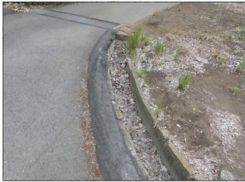
側溝清掃（落ち葉除去前）
