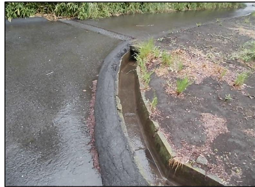
側溝清掃（落ち葉除去後）
