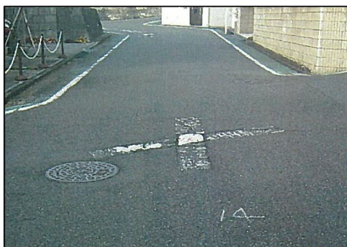
安全施設の補修（区画線補修前）
